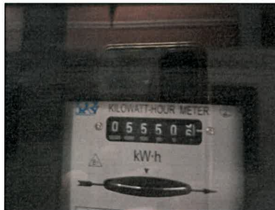
รูปที่ 3-36 มิเตอร์ไฟฟ้าสำหรับระบบบำบัดน้ำเสียโดยเฉพาะแยกจากระบบไฟฟ้าอื่นๆ
